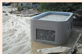
▲被災当時土砂でトイレが埋まった八敷公園
