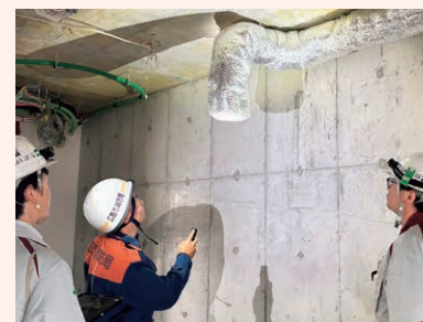
設備などの設置状況の確認
