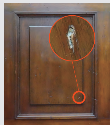
支店長室腰板に残る傷。 ガラス片が残っている部分も
