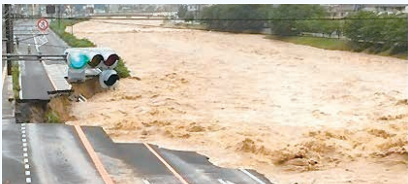
▲平成30年7月豪雨の被害の様子(中野東 国道2号平原橋付近)
