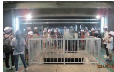
◀微生物により汚水を分解するタンクの見学
