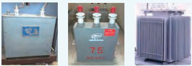
低圧コンデンサー 電力用コンデンサー 変圧器 (写真提供:環境省)
