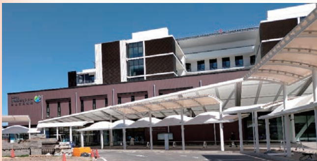
新病院前バス乗り場(令和4年4月撮影。工事中)
