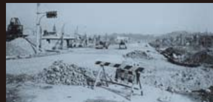
平和大通りの整地作業風景
