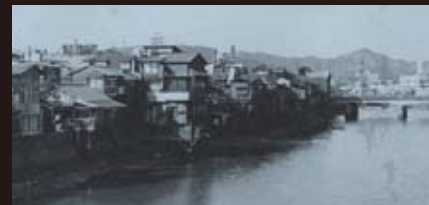
不法建築が建ち並び猿猴川護岸
