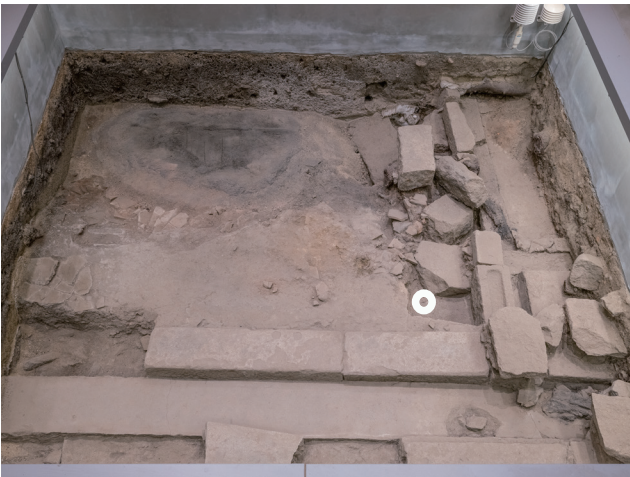
白丸部分に亀裂を確認した
