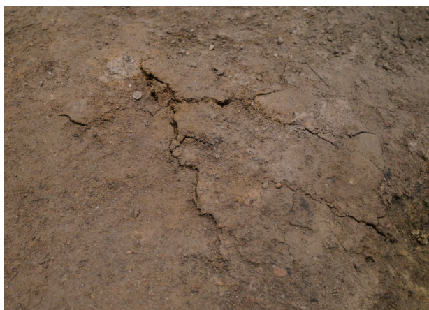
2024/2/15 亀裂 縦約 11.4cm 横約 19.6cm 亀裂が硫酸塩が析出した場所まで広がっている。
