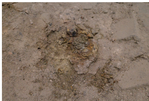
2023/9/14 析出物除去後の様子。
