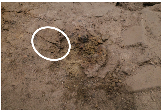
2024/2/15 析出物は除去後から大きな変化はみられない が、析出物周辺に5cm程度の亀裂を確認した。
