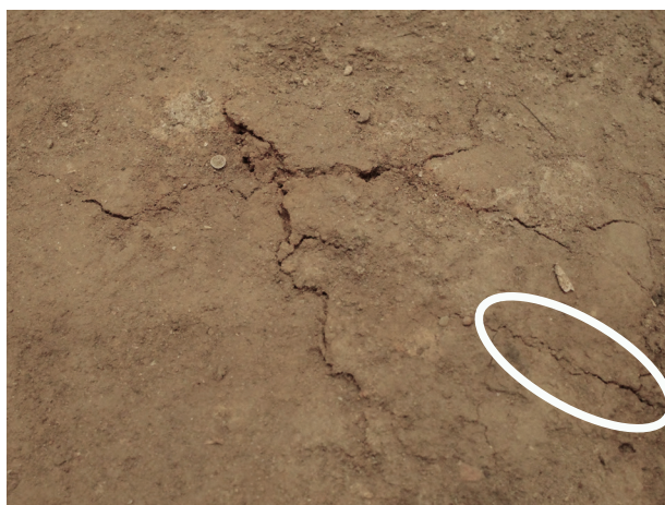
2024/1/18 亀裂 縦約 11.2cm 横約 17.7cm 白丸部分に新たな亀裂を確認した。
