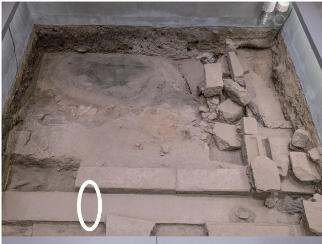
白丸部分に亀裂を確認した
