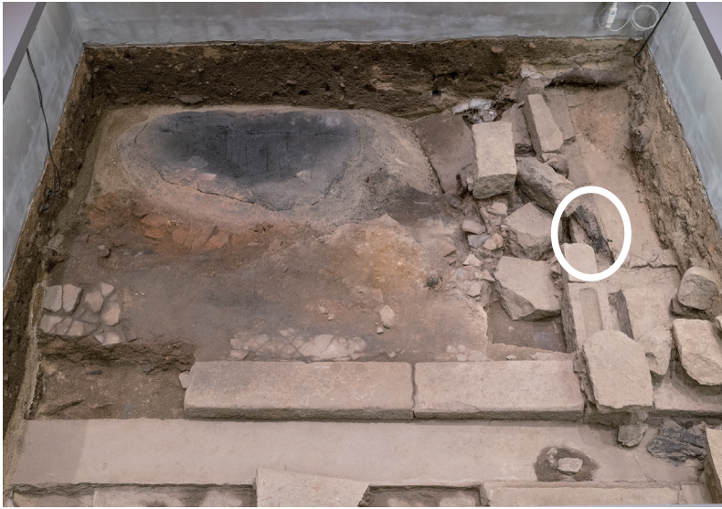
R4/5/16 丸印の部分が崩壊。
