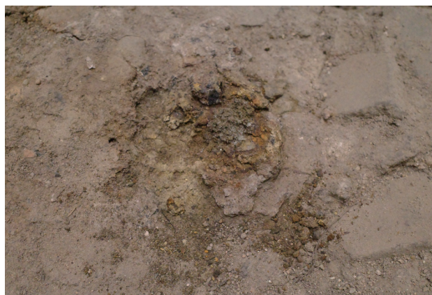
2023/9/14 析出物除去後の様子。
