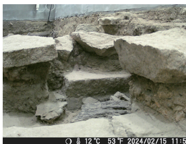
2/15 定点カメラ画像 崩壊後から変化は見られない。
