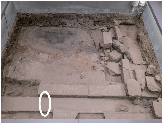
白丸部分に亀裂を確認した
