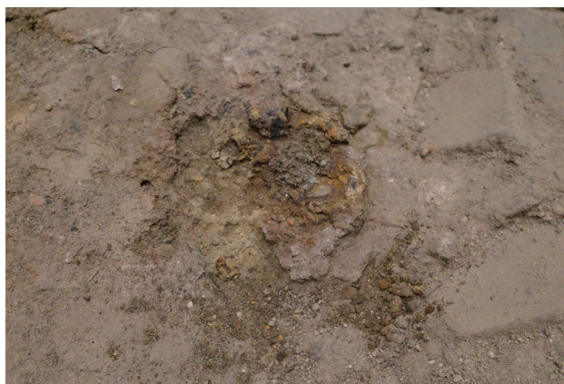
2023/9/14 析出物除去後の様子。
