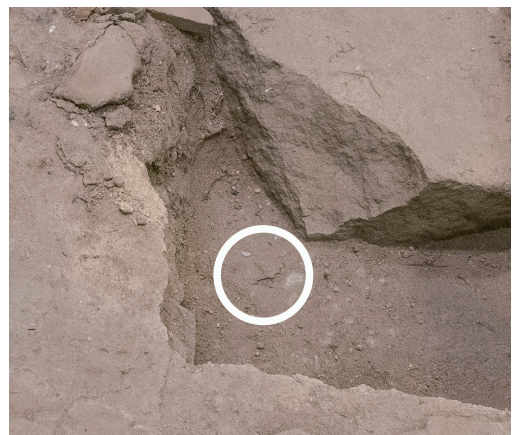
2022/8/24 拡大写真 亀裂がはじめて確認された
