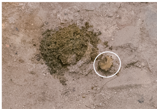
2023/10/13 表面全体が茶色く変化している。 表出した部分※が周囲に崩れ落ちているこ とがわかる。 ※白丸の部分
