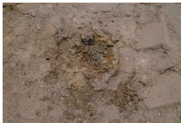
9/14 析出物除去後の様子。
