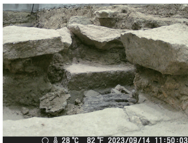
9/14 定点カメラ画像 崩壊後から変化は見られない。
