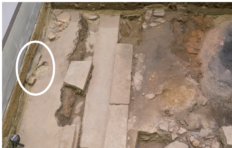
R4/5/16 丸印の部分が崩壊。
