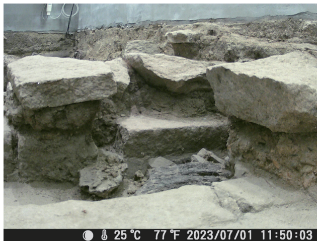
7/1 定点カメラ画像 5/23 時点から変化はない。
