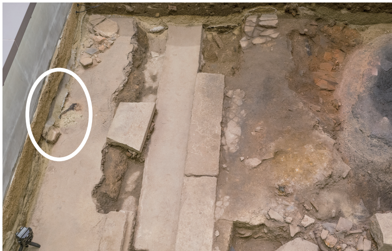
R4/5/16 丸印の部分が崩壊。
