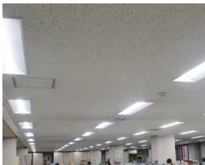
LED照明を利用したオフィス
