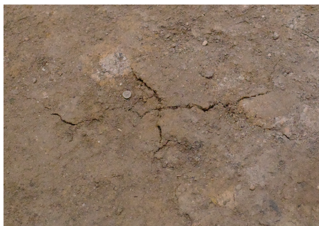
2/15 亀裂の範囲 東西方向：9.3 cm程度 南北方向：4.8 cm程度
