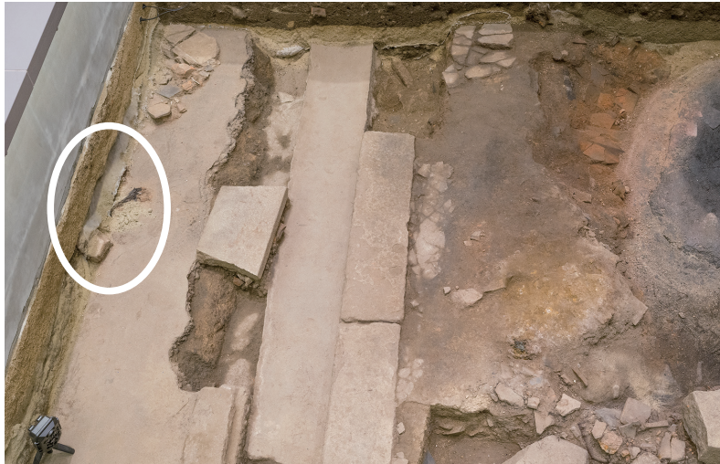
5/16 丸印の部分が崩壊。
