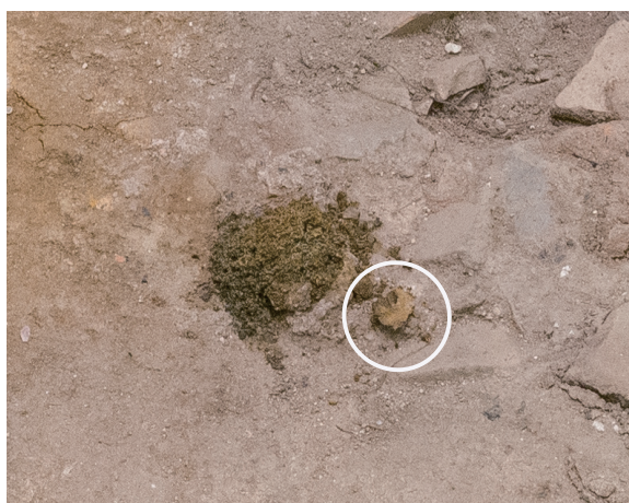
10/13 表面全体が茶色く変化している。 表出した部分※が周囲に崩れ落ちていることがわかる。 ※白丸の部分
