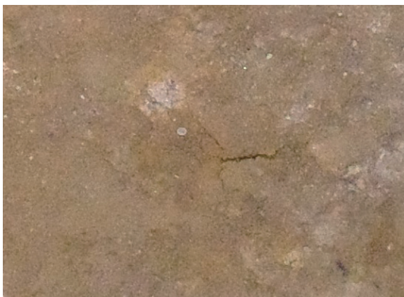
10/13 東西方向に3.76 cm程度、南北方向に3.96 cm程度の亀裂がある。
