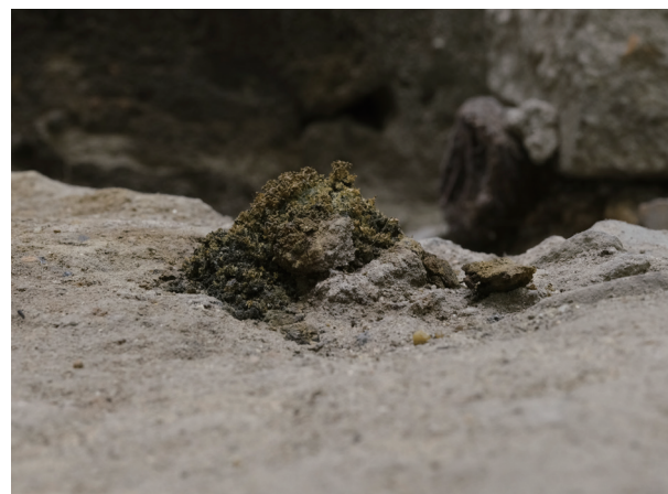
10/13 横から見ると、下層部が表出していることがよくわかる。
