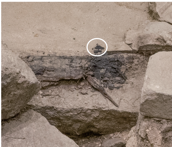
7/14 丸印の部分が6月よりも崩れ ている。
