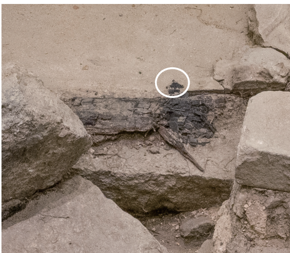
7/14 丸印の部分が6月よりも崩れ ている。
