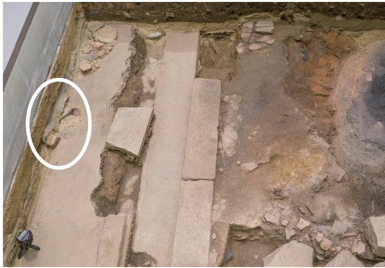
5/16 丸印の部分が崩壊。
