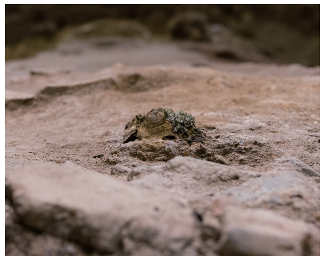
6/16 塩が析出したと思われる場所は、横から見ると隆起している。
