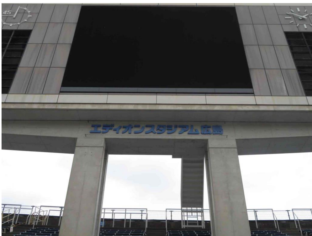
④広島広域公園陸上競技場 大型映像装置
