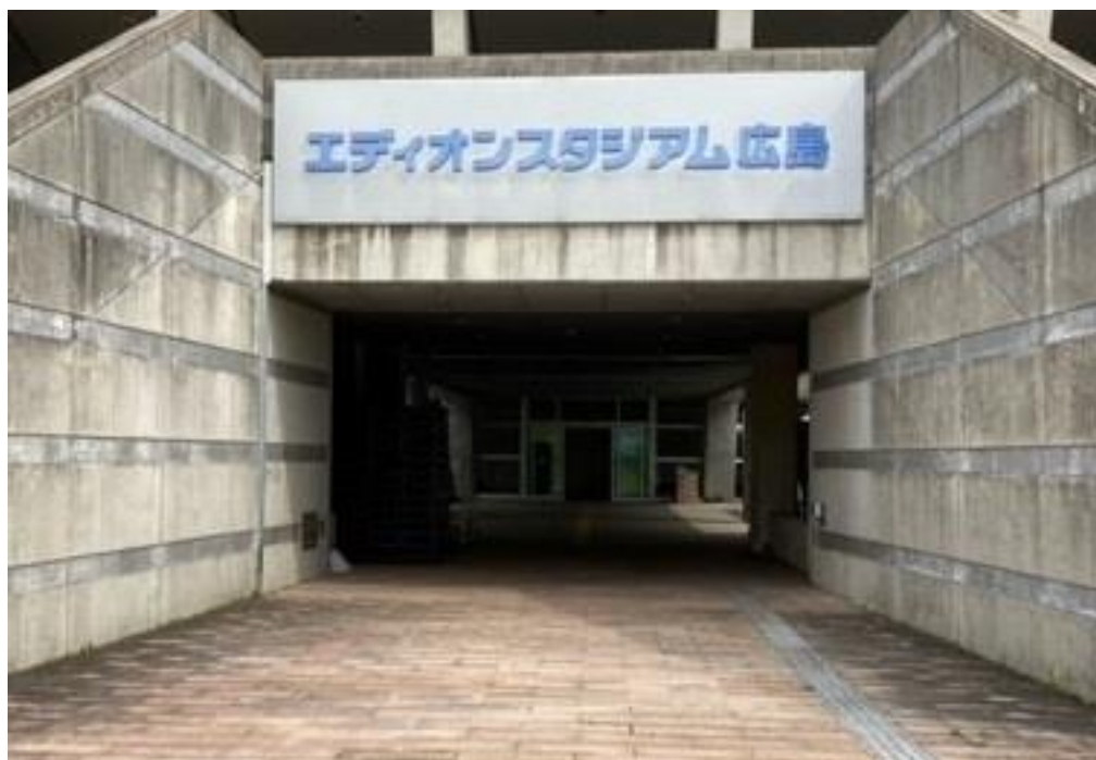
②広島広域公園陸上競技場 入口2
