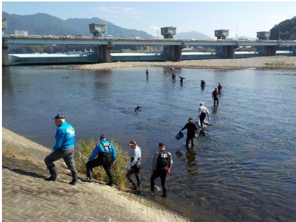
④河川への設置作業
