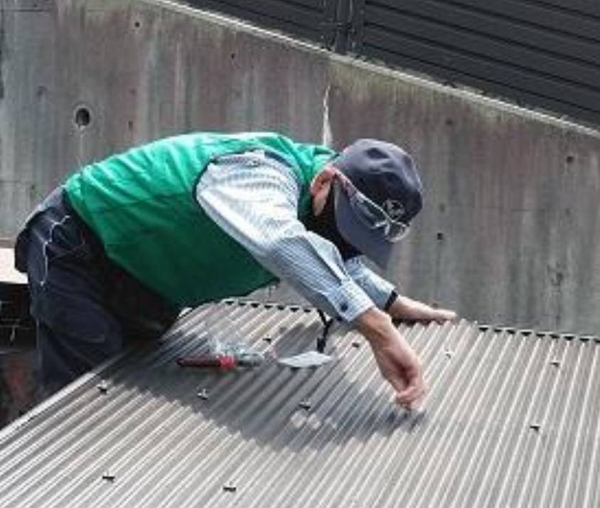
倉庫屋根補修
