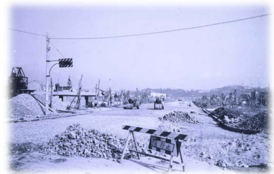
建設中の100m道路（昭和23年頃）
