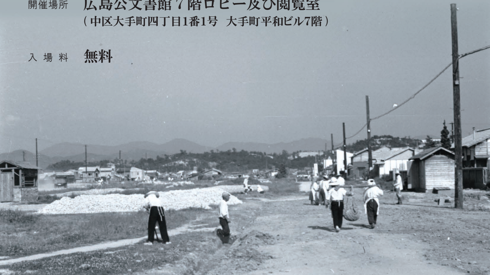
建設中の平和大通り（昭和27年）明田弘司 撮影
