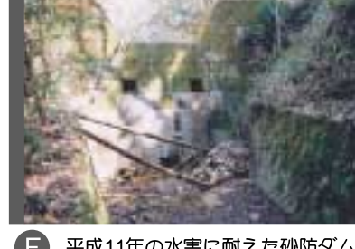
E 平成11年の水害に耐えた砂防ダム
