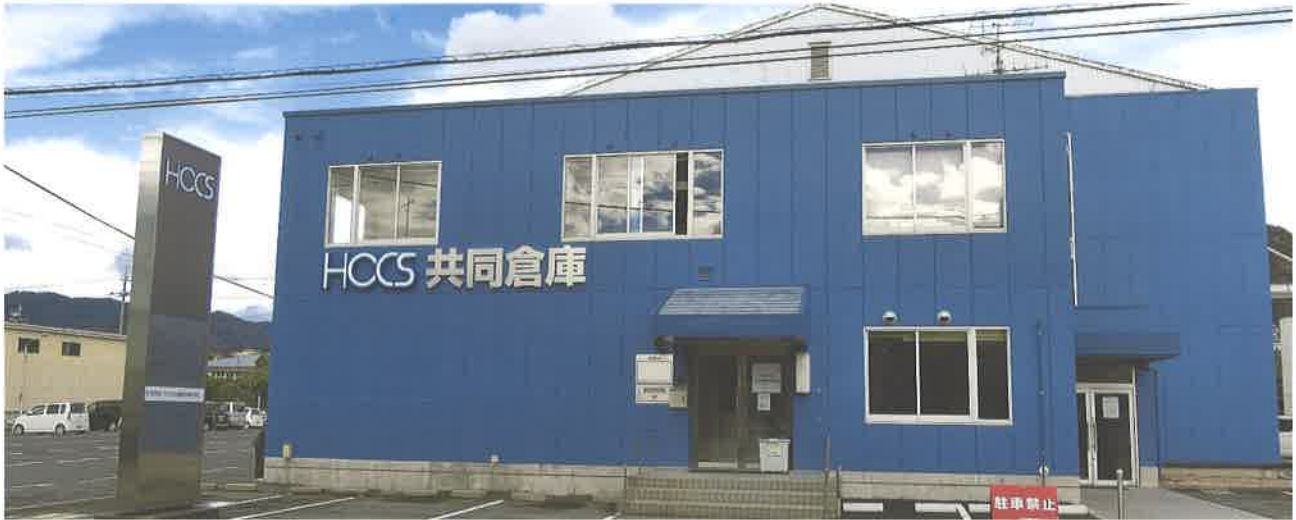
組合共同倉庫 事務所の新設
