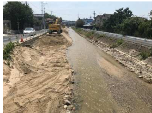
府中大川に堆積した土砂の浚渫工事の様子
