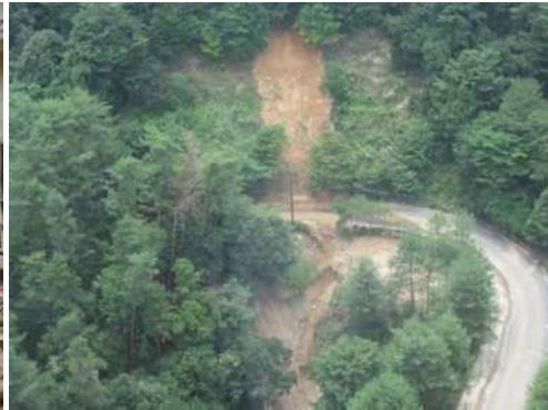
土石流発生の起点となった林道法面の崩壊箇所
