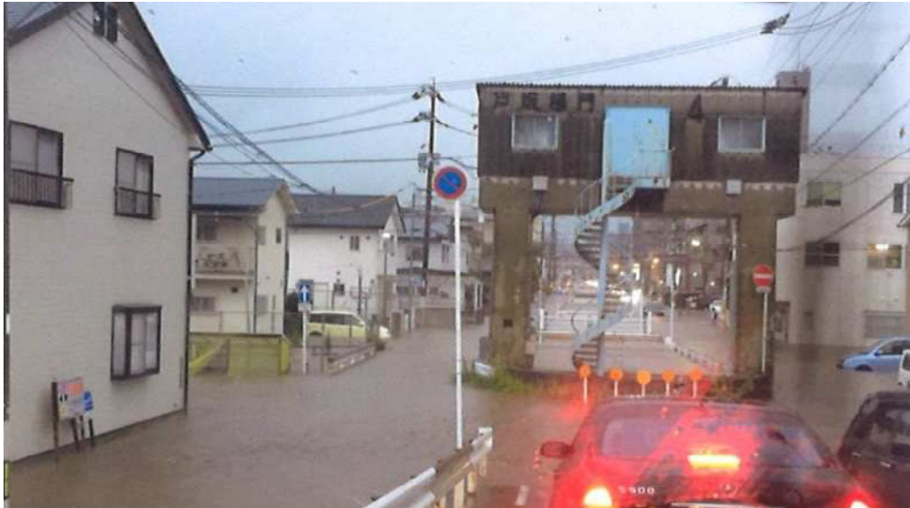
浸水した戸坂樋門付近
