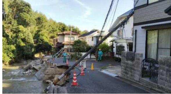
府中大川護岸の崩壊により倒れた電柱
