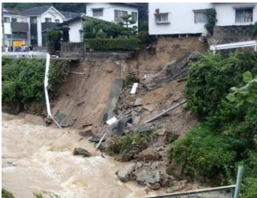
府中大川護岸の崩壊により崩落した道路と家屋の基礎部分
