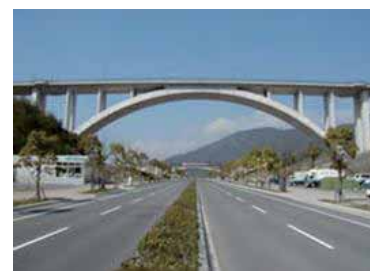
〔デザインに配慮した橋梁〕
