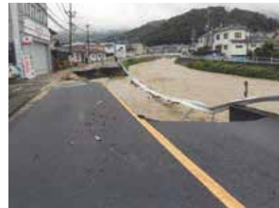
主要地方道東海田広島線(安芸区)
