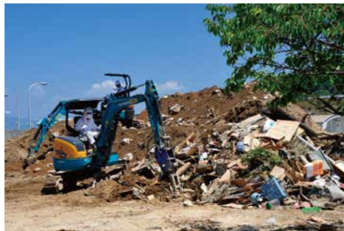
復旧作業の様子(似島)
