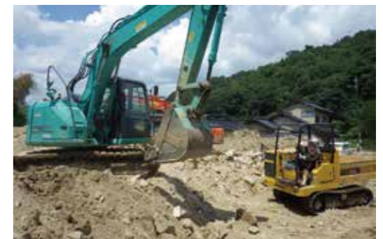
民有地土砂撤去の作業状況
