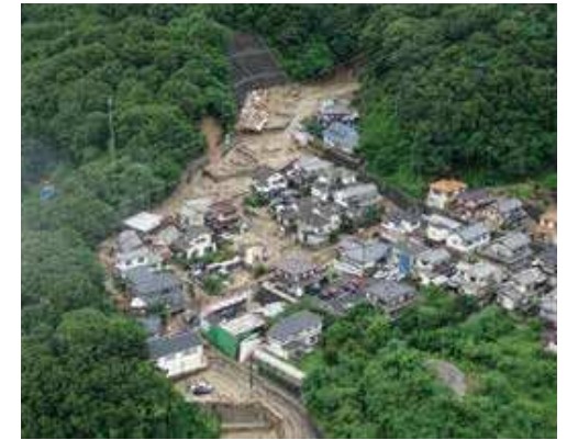
安芸区矢野東の土石流
