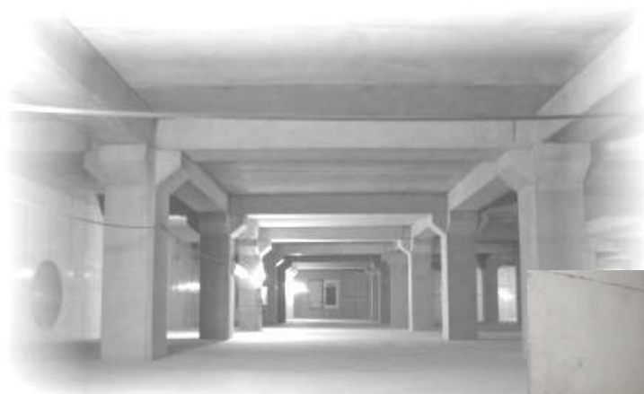
大州雨水貯留池の内部
