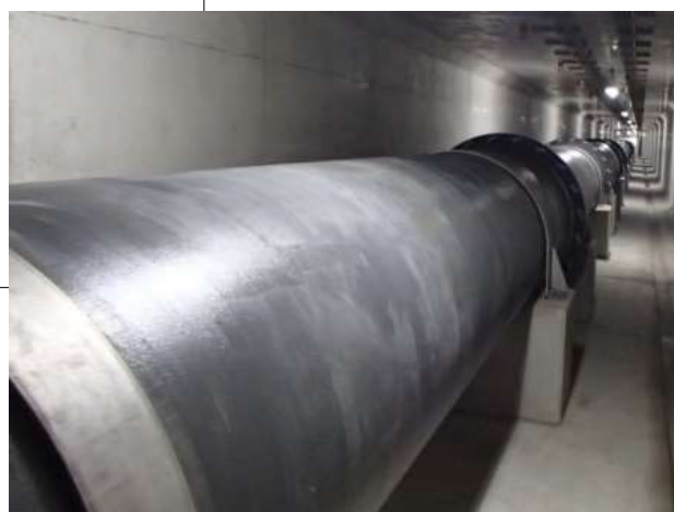
水道施設の相互連絡管整備 (バックアップ機能の強化)
