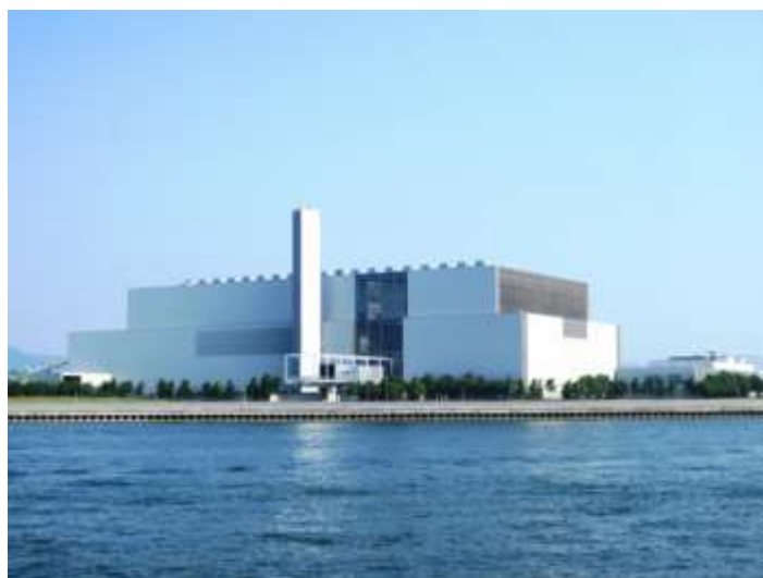
中工場（ごみ焼却施設）平成16年4月に稼働。焼却能力は200トン／日×3炉。 工場のデザインは、世界的に有名な建築家である谷口吉生（たにぐちよしお）氏の設計
