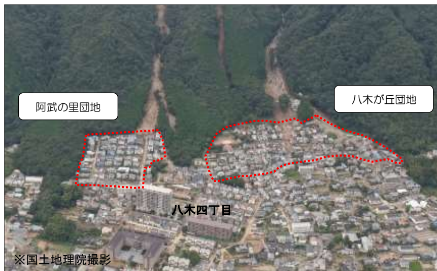
図表 34 平成26年8月20日に発生した「8・20豪雨災害」 安佐南区八木地区の住宅団地の被災状況
