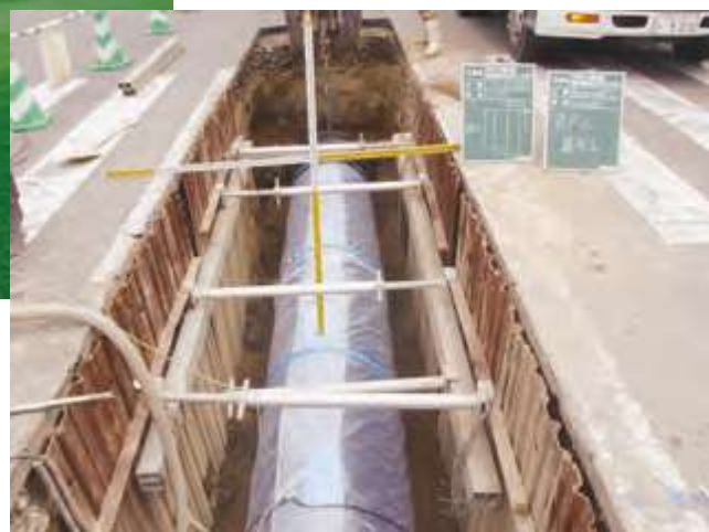
水道施設の排水幹線の相互連絡管整備工事 （バックアップ機能の強化）
