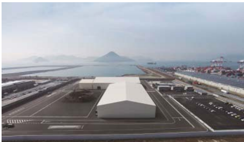
写真 3-5-1 災害廃棄物中間処理施設
