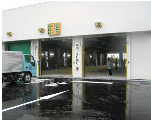
写真 1-2-7 西部水資源再生センターし尿等投入施設
