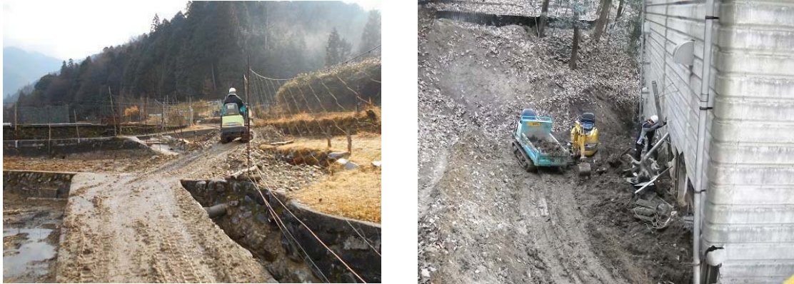
写真 2-4-1 民有地からキャタピラ式小型ダンプ車での撤去状況
