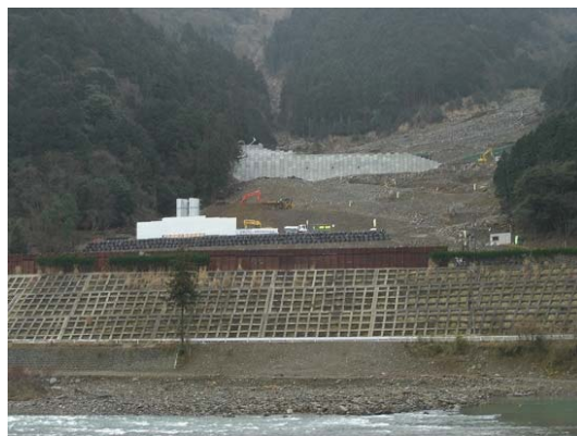
写真 1-2-8 宇津し尿中継地（平成 28 年 2 月撮影）
