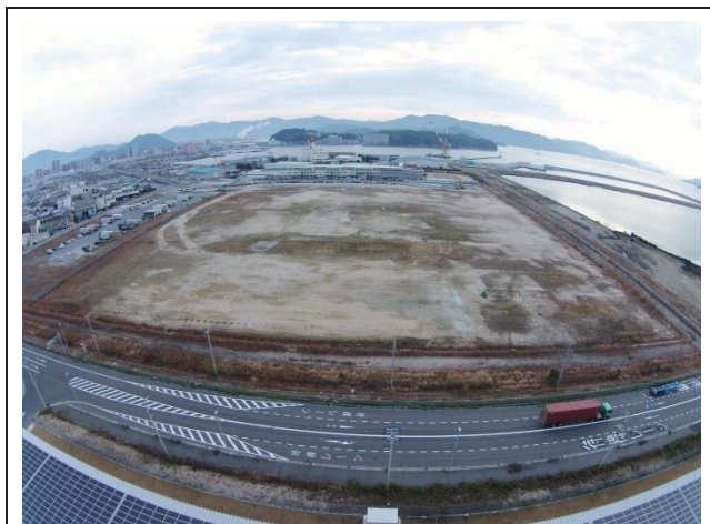
【H26.12.8 現地状況】
