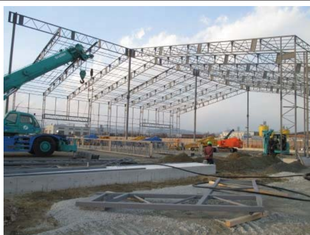
【H27.1.11 仮設テント設置工】
