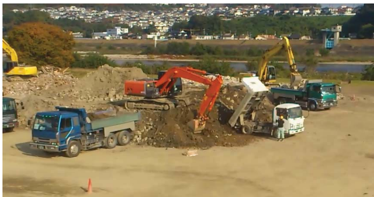
写真 1-1-10 太田川河川敷の積替場
