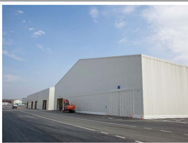
【H27.3.10 現地状況】
