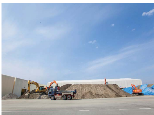
災害廃棄物中間処理施設 【H27. 3.20 処理状況（分別土砂）】
