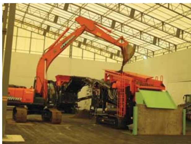
災害廃棄物中間処理施設 【H27.1.30 選別作業①（試運転）】
