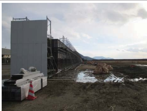
【H27.12.22 仮囲い設置工】
