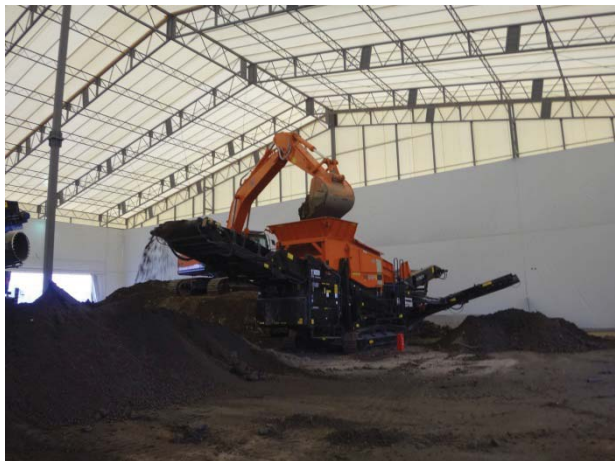
災害廃棄物中間処理施設 【H27. 3.13 一次分別作業①】
