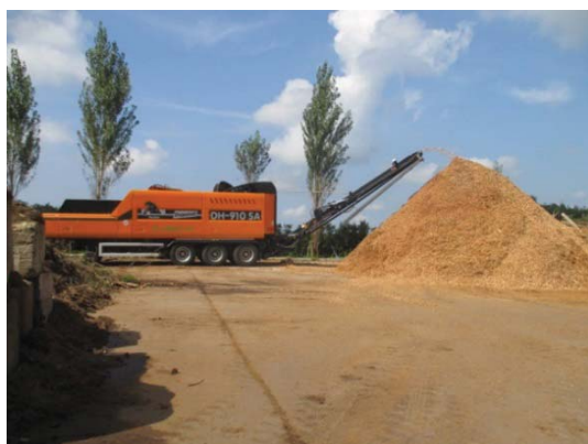
写真 3-5-20 チップ化（破碎処理）
