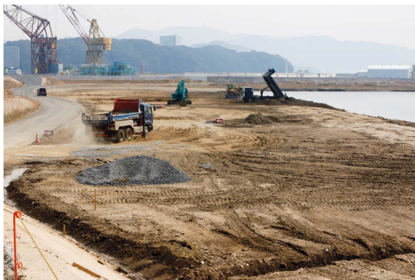
写真 4-3-1 分別土砂が第3工区で埋め立てられている様子 （2次仮置場から撮影）
