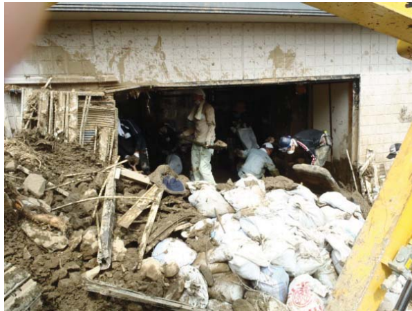
写真 1-5-2 ボランティアによる土砂等撤去
