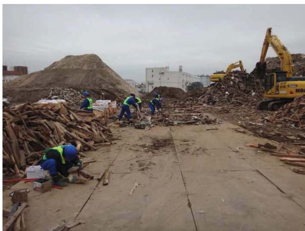
7 下水道局西部水資源再生センター用地 【H27. 2.26 作業風景】
