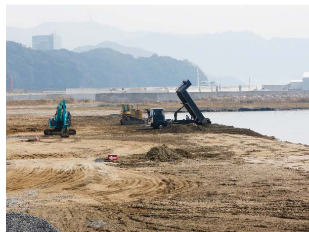
広島港出島地区埋立事業地第3工区 【H27. 3.20 土砂（埋め立て）】
