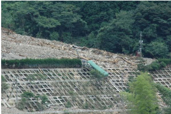
写真 1-1-7 宇津し尿中継地被災状況
