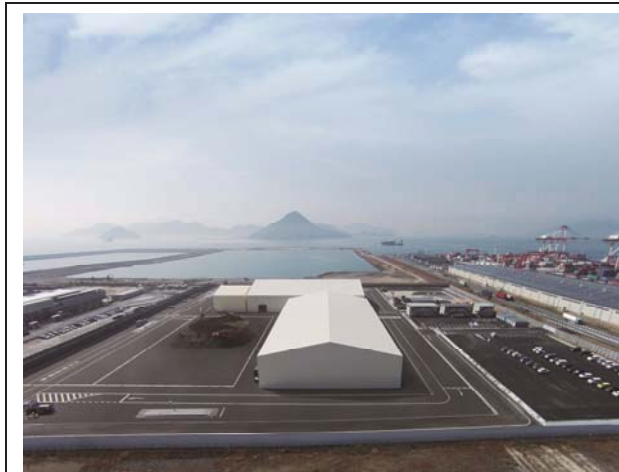
【H27.3.10 現地状況】
