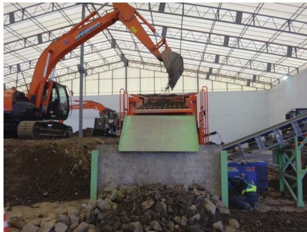
災害廃棄物中間処理施設 【H27. 3.13 一次分別作業②】
