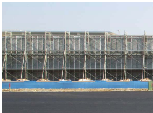
写真 3-5-25 防音対策を講じた仮囲い
