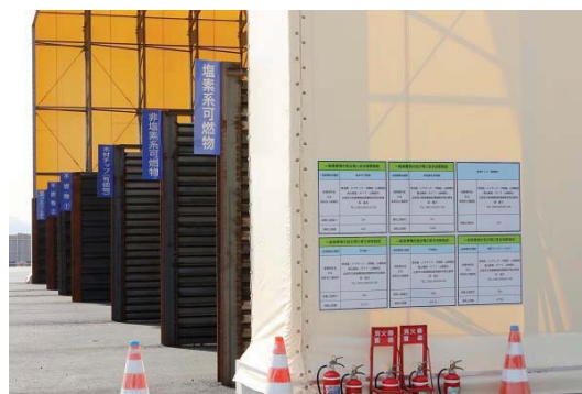
写真 3-5-23 処理後物保管ゾーン
