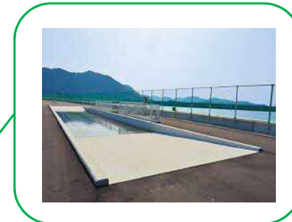
①工事用車両用
