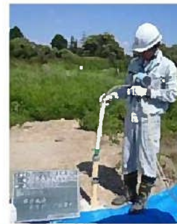
写真-2 水中ポンプの挿入状況
