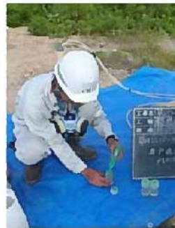
写真-1 孔内水位の測定状況
