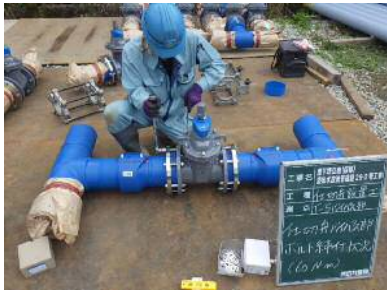
バイパス部組立状況
