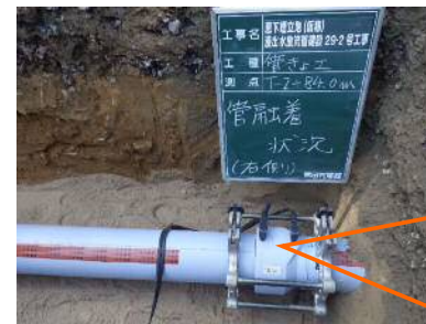
管接続・融着状況
