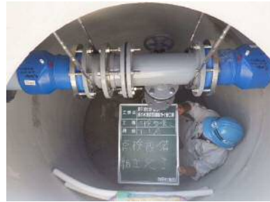
マンホール内
