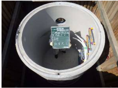
組立マンホール設置
