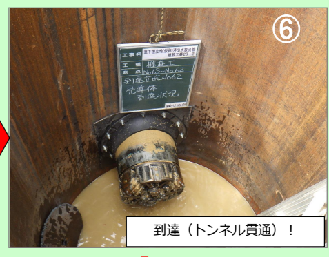
掘進した土は泥水管を伝って 地上まで送られてきます
