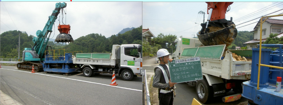
③圧入掘削・残土積込搬出
