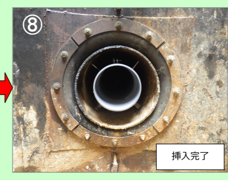
貫通した穴に塩ビ管φ200mm を挿入します
