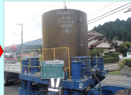
②ケーシング建込み・圧入回転
