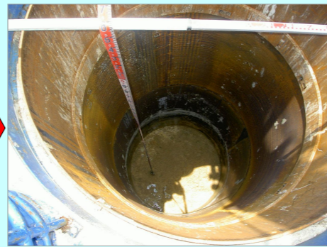
④圧入掘削完了
