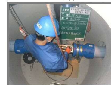
自走式カメラ挿入状況
