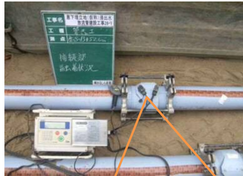
管接続、融着状況
