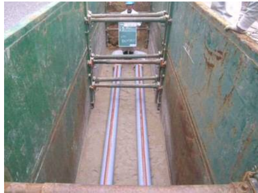
管路及びマンホール設置
