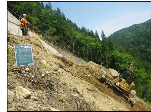
②法面工（高所掘削）
