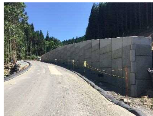
④補強土壁工
