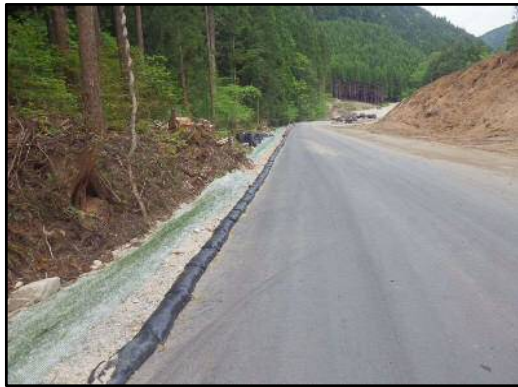
作業用道路工
