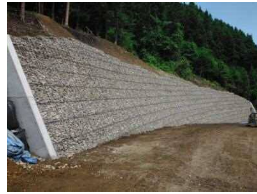
①大型かご枠工
