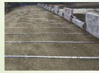
補強土壁(テールメ工法) L=440m
