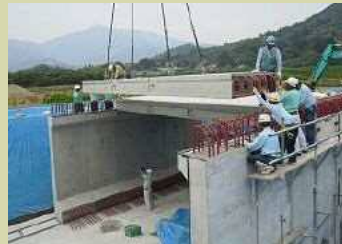
函渠(ボックス) [2箇所]
