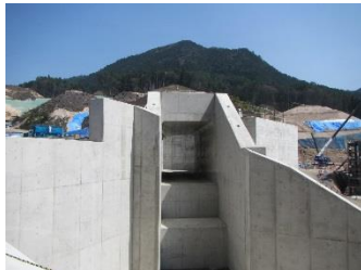
②余水吐放水路
