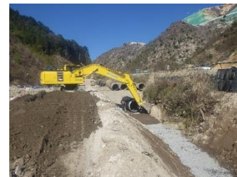
④地下水集排水工
