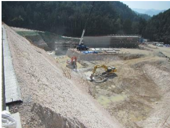
①-2防災調整池（掘削）
