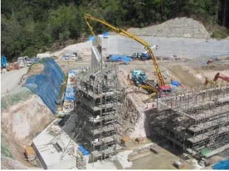
①-1防災調整池（擁壁）
