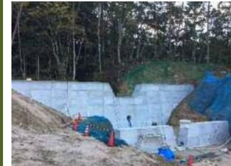
南溪流の土石流を防止する堰堤を施工しています。
