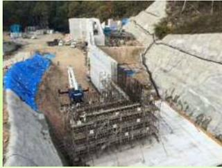
防災調整池Hブロックの底板コンクリート打設を終え、続けて壁部のコンクリート打設します。
