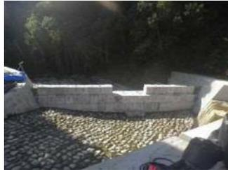
土砂流出防止のため、場内河川下流部にコンクリートブロック仮設堰堤を設置しました。
