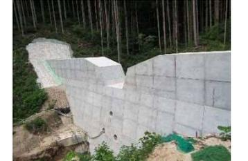
北溪流部の土石流を防止する堰堤を施工しています。
