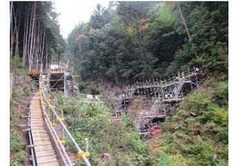
北溪流部に堆積した土砂が下流に流出しないよう待ち受け型の土砂止めワイヤーネットの施工を行っています。
