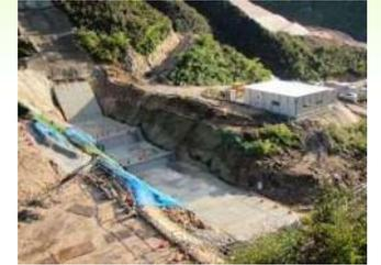
浸出水の流出を防止する不透水層を構築する岩盤グラウト注入を行うためのカバーコンクリートを打設しました。
