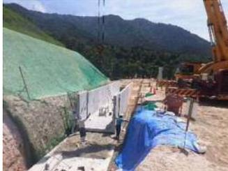
クレーンを使用して大型水路の掘付作業を行っています。
