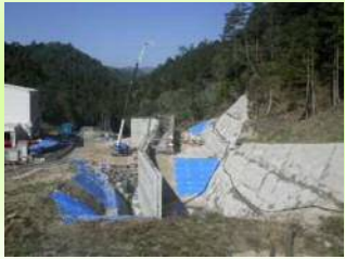
①防災調整池工
