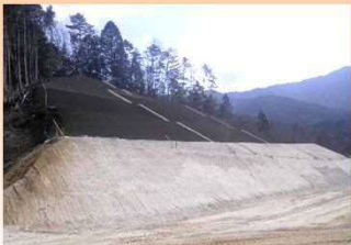
③-1 法面保護工
