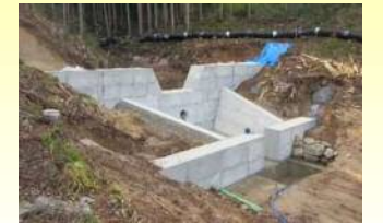
⑦砂防堰堤工
