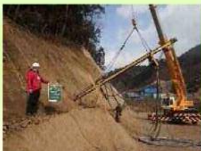
②法面補強工 (鉄筋挿入工・モルタル吹付)
