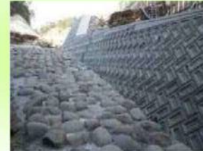
④ブロック積工
