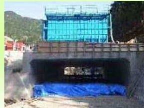
③ボックスカルバート工
