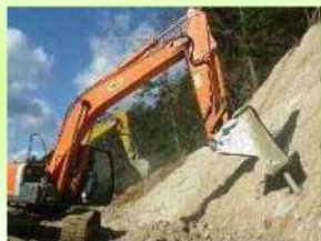
①防災調整池部の法面掘削
