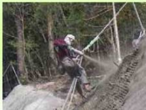
②法面補強工 (鉄筋挿入工・モルタル吹付)
